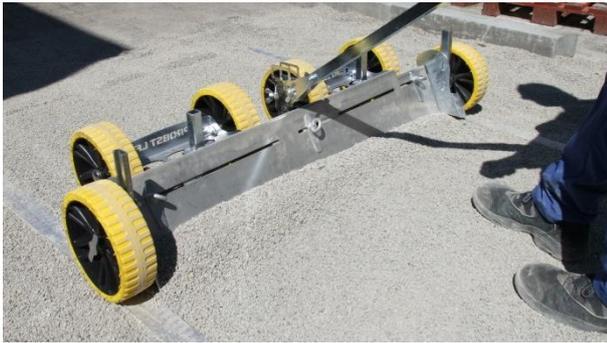
Zum exakten Planieren muss die Laufhöhe der Räder auf die Höhe der Abziehbleche eingestellt werden.
