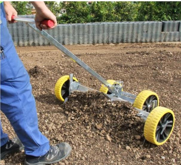
Um ein gleichmäßiges Niveau für das Planum zu erzeugen, wird die Laufhöhe der Räder auf den Wert „0“ eingestellt. Der Wert kann auf der Einstellskala abgelesen werden.
